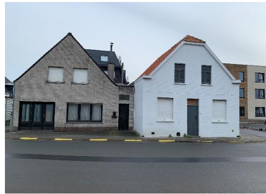
Foto 16: Bebouwing Duinenstraat 108 en 110. Rechts = vastgesteld bouwkundig erfgoed.
